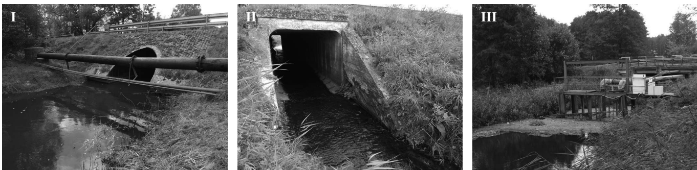
Fot. 6. Budowle wodne na odcinkach badawczych RHS: I most na Lewińskiej Strudze – odcinek B, II przepust na Dopływie z Wielkich Peł – odcinek G, III budowla poprzeczna na Starym Zdroju – odcinek D Photo 6. Water constructions on RHS research sections: I bridge on Lewińska Struga – B section, II culvert on Inflow from Wielkie Peł – G section, III cross construction on Stary Zdrój – D section
