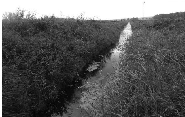
Fot. 4. Dopływ z Wielkiego Pła, odcinek badawczy G Photo 4. Inflow from Wielkie Pła, G reserach section
